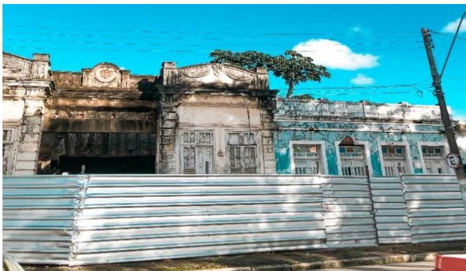
Imagem 3. Prédios tombados isolados no bairro do Bebedouro. Foto: Revany Dayane F. Félix da Silva /2022
