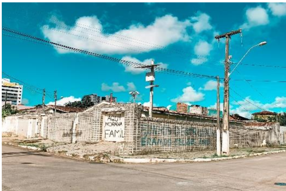
Imagem 2. Rua no Bairro do Pinheiro. Cabos de energia furtados. Foto: Revany Dayane F. Félix da Silva /2022
