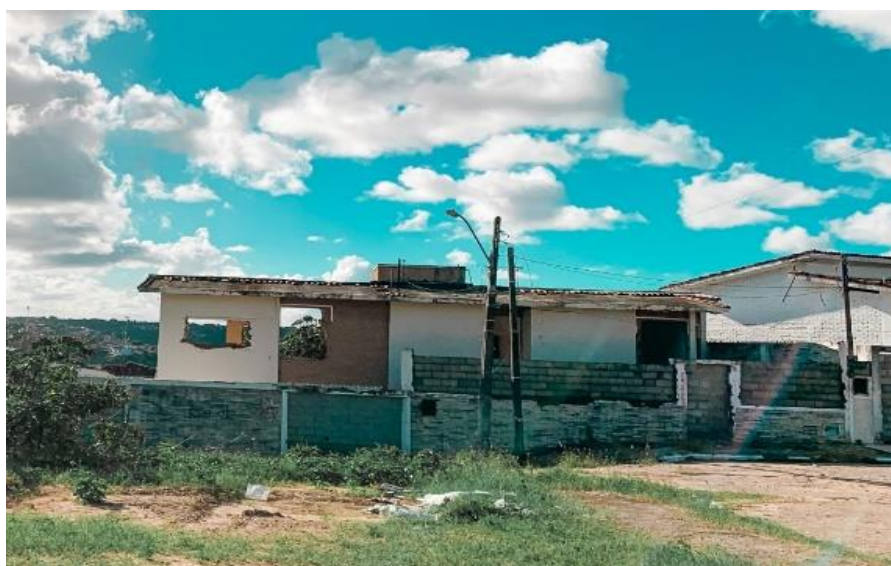
Imagem 1. Imóvel abandonado no bairro do Pinheiro. Foto: Revany Dayane F. Félix da Silva /2022
