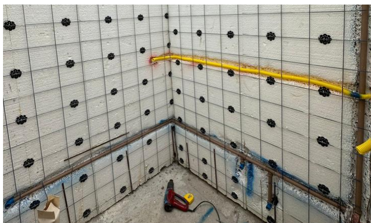
Figura 7. Processo executivo: passagem das instalações.
