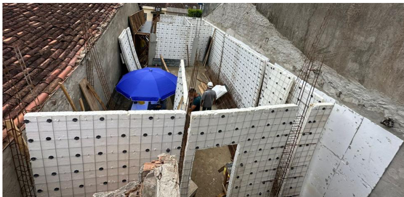
Figura 4. Processo executivo: modulação das paredes.
