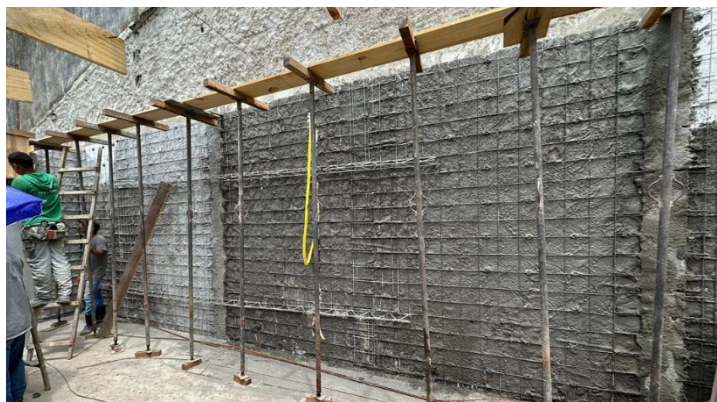
Figura 6. Processo executivo: alinhamento dos painéis.
